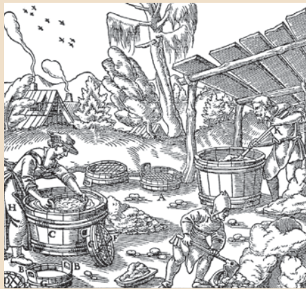
Abb. 46: Roherz-Reinigung mit Wasch-Sieben zur AGRICOLA-Zeit
