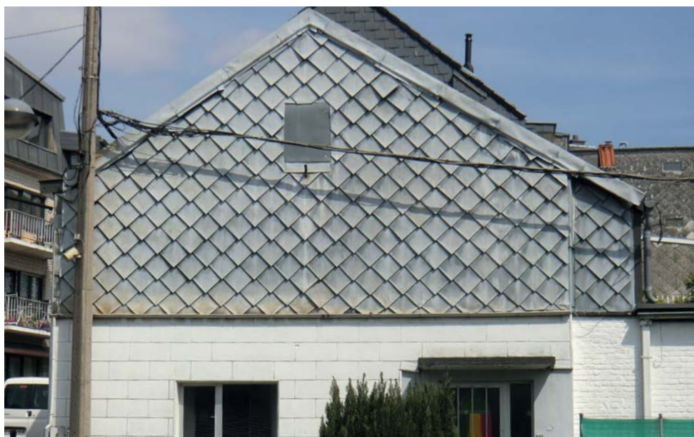
Abb. 61: Fassadenverkleidung mit Zinkblech-Patentrauten, Kelmis
